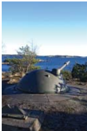
Batt OD, 1.pjäs 7,5 cm M/57. Bildkälla Lars A Hansson/ bunkertours.se
