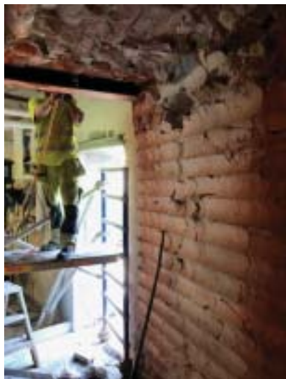
En reservutgång borrar igenom 1,8 meter i det gamla befästningsverket linje IV. Foto Lennart Larsson
